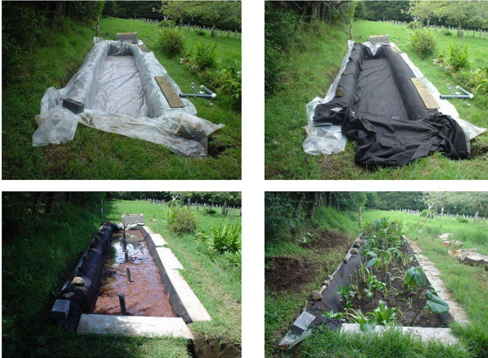
**Foto 3.** Construcción del humedal por etapas. A la derecha del canal se observa el precultivo de las plantas.
